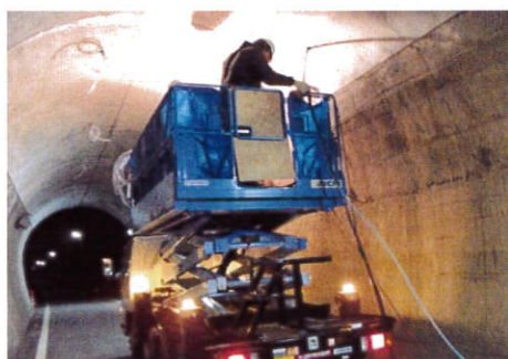
道路トンネル裏込注入状況
