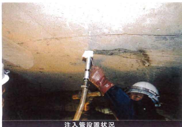
注入管設置状況
