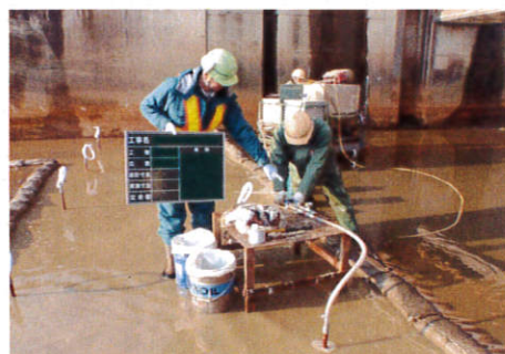
水門底板部空洞充填状況
