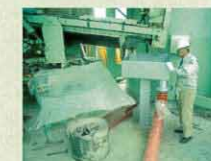
ミキサーの洗浄水
